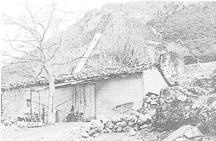
Ο παλιός Νερόμυλος του Σπύρου Κουλάκη με το μυλοθάγενο που έριχνε το νερό για να αλέσει. Μακάρι κάποτε να μπει κάποιος μύλος σε λειτουργία.
